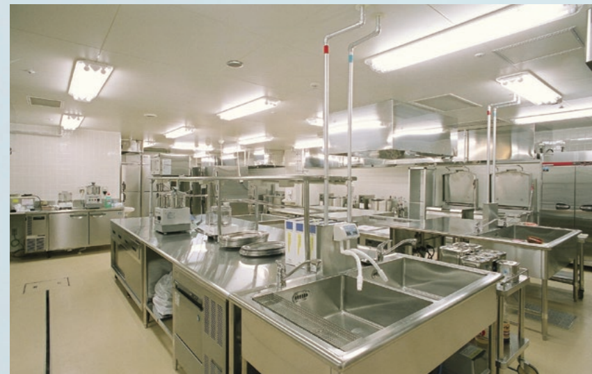
＊オール電化の病院厨房
